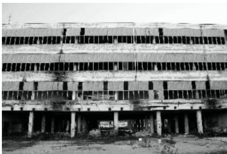
Sl. 14. Napuštena zgrada Boris Kidriča u centru grada
