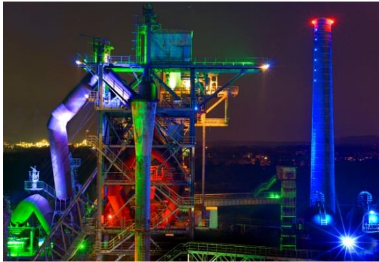
Sl. 18. Pogled na preuređeni Zeche Zollverein po noći Izvor: URL 18.
