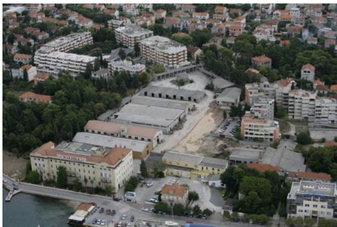
Sl. 26. Zapuštene površine tvornica Maraske i Jadranka
