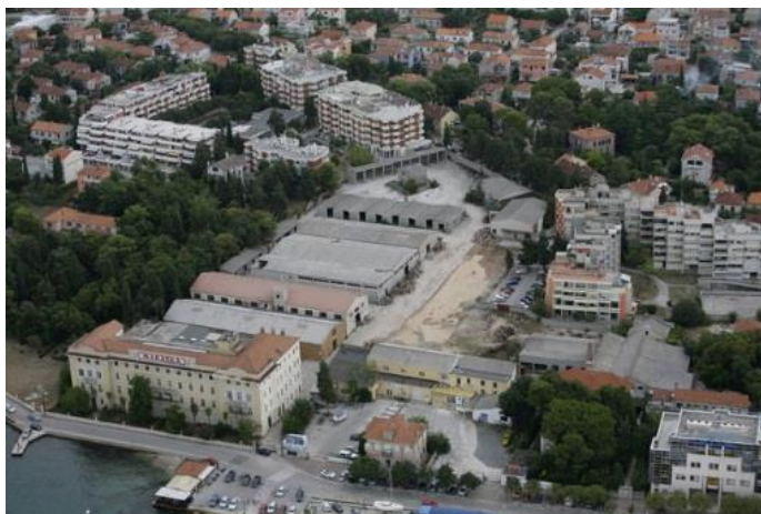
Sl. 26. Zapuštene površine tvornica Maraske i Jadranka
