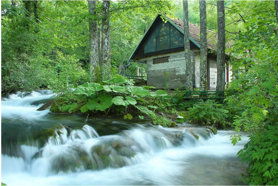
Sl.14. Šušnjarov slap prije gradnje protočne hidroelektrane Izvor: KAportal, 2016
