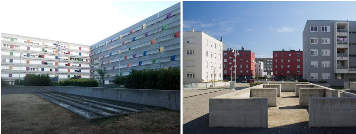
Sl. 5. i Sl. 6.: Stambeni blokovi unutar naselja, takozvani „megastruktura“ (blok A) i „elipsa“ (blok D)
