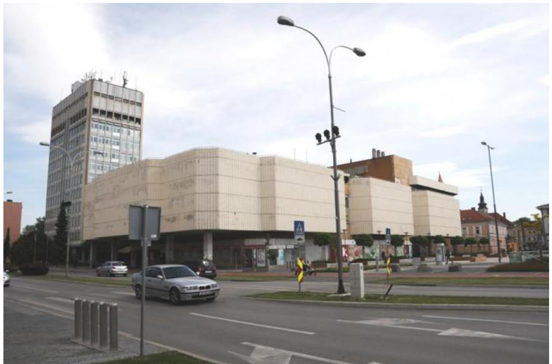
Slika 12. Kapucinski trg sa zgradom Vodotornja u zaleđu robne kuće VAMA (URL 9)
