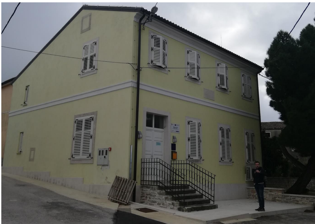
Sl. 13. Hostel u zgradi nekadašnje područne škole u Tribanu
