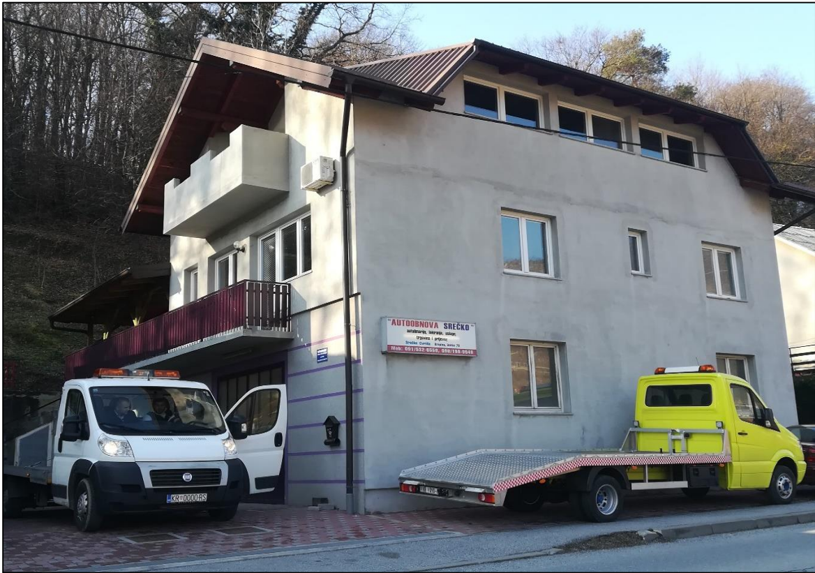
Sl. 8. Primjer mješovite namjene objekta (u prizemlju autolimarska radionica, a na katu stambeni prostor)
