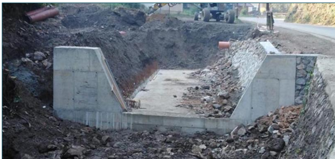
Sl. 15. Početni radovi na regulaciji vodotoka Rudarska Gradna u Rudama Izvor: www.zgprsten.hr
