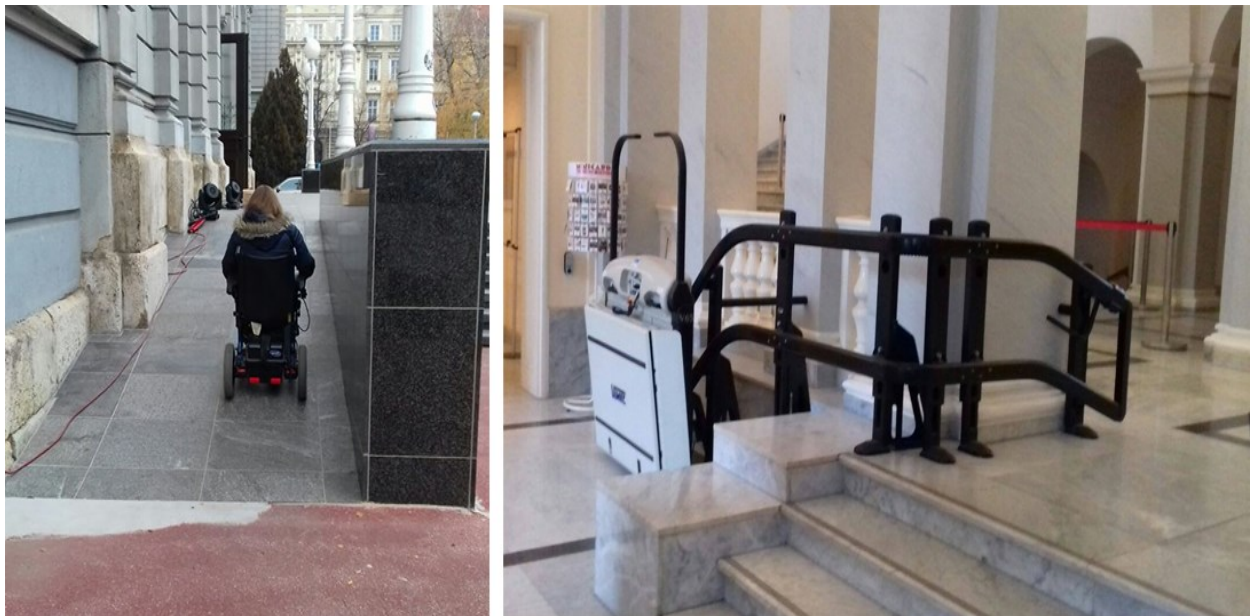
Sl. 11. Primjeri elemenata pristupačnosti muzejima – kosina i podizna platforma
