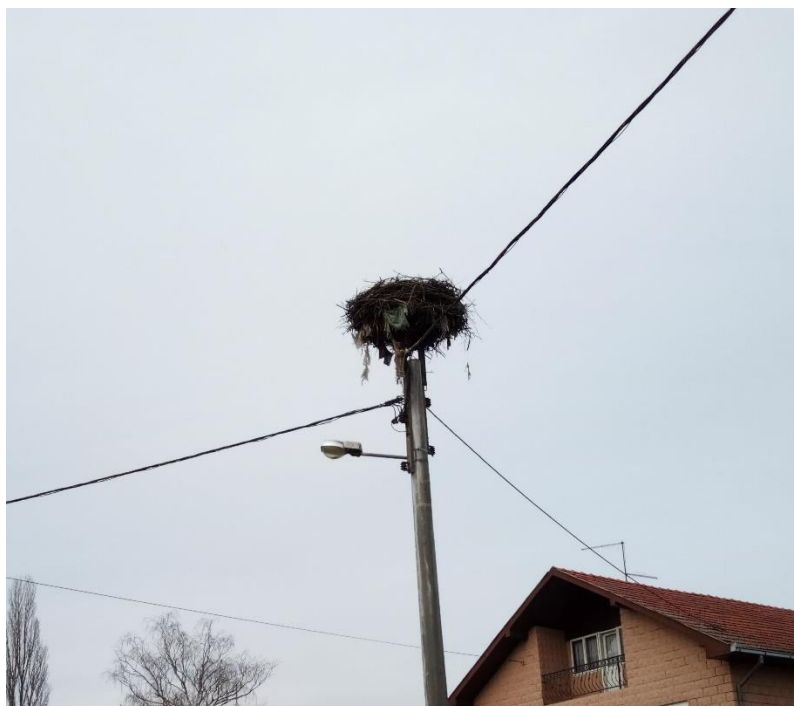
Slika 6. Platforma za gnijezdo (niskonaponska mreža)
