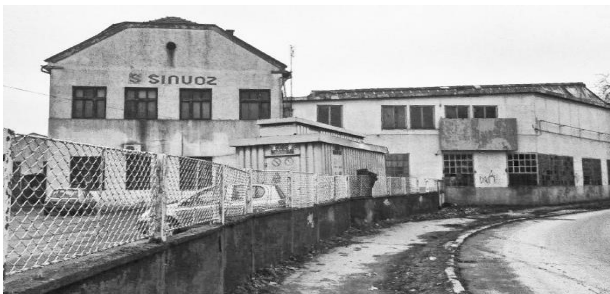
Sl.8: Napušteni hangari i postrojenja tvornice „Šinovož“
