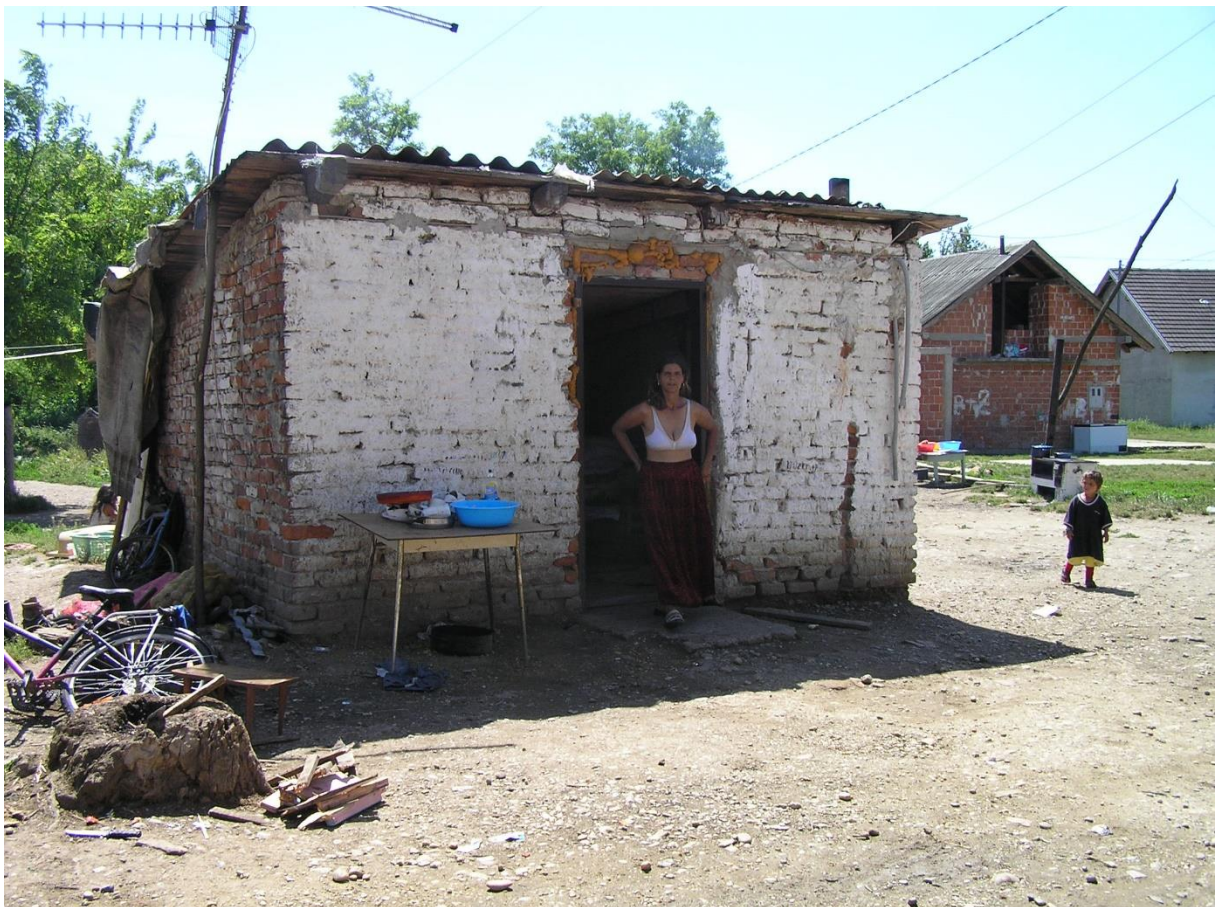
Sl. 55. Površinom mali i izvedbom nekvalitetan stambeni objekt u romskom naselju Piškorovec Foto: H. Šlezak, 2010.
