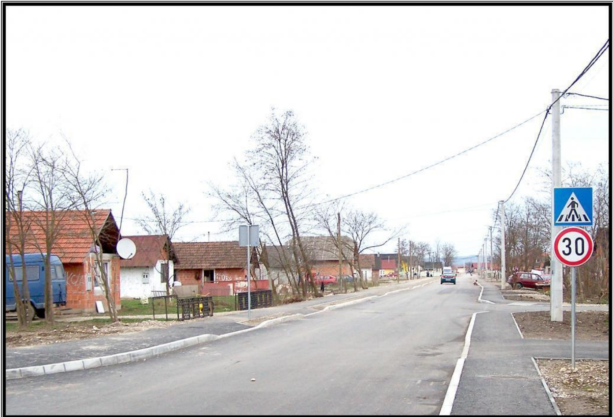
Sl. 37. Romsko naselje Piškorovec neposredno nakon infrastrukturnog uređenja Foto: medjimurje.hr
