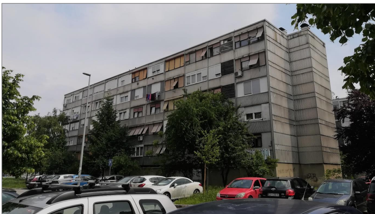
Sl. 48. Jugomontova stambena zgrada u Remetinečkom gaju (18. 05. 2019.)
