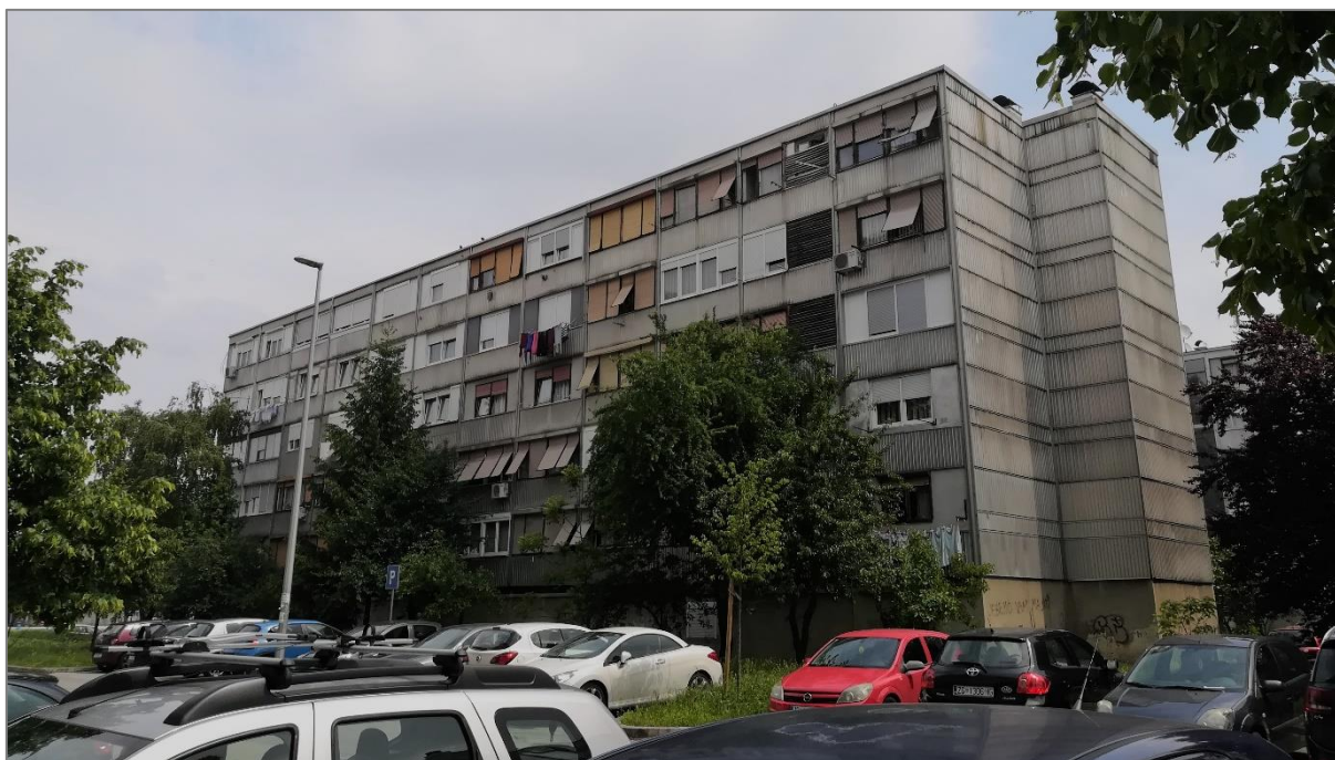
Sl. 48. Jugomontova stambena zgrada u Remetinečkom gaju (18. 05. 2019.)
