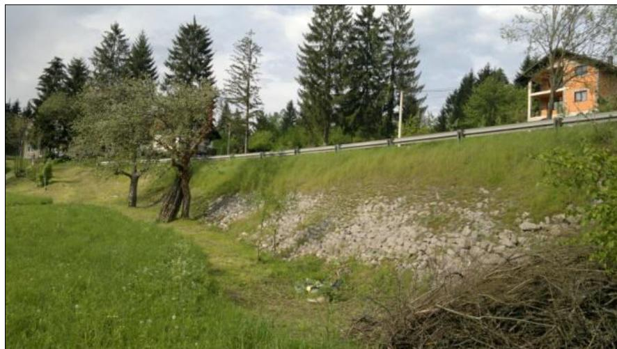
Slika 225. Cestovni nasip s visokim podzidom od tesana kamena između Stubice i Nadvučnika (P. Feletar, 2014.)
