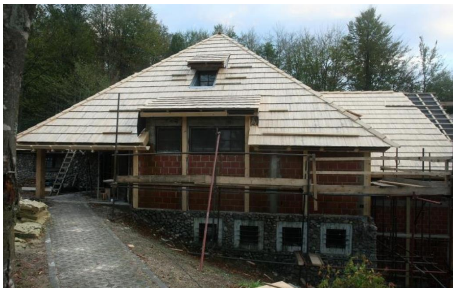
Slika 29. Obnova tradicionalnog restorana Lička kuća (Foto: Marković, I., 2014.)
