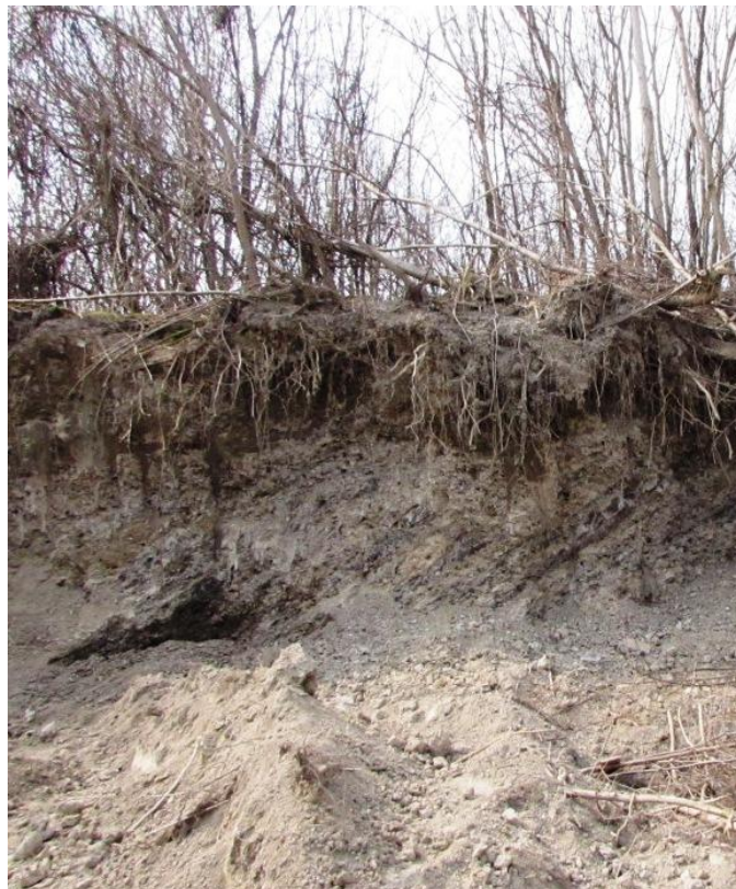
Sl. 36 Prikaz procesa osipanja na haldi 21 (22. 03. 2015.)
