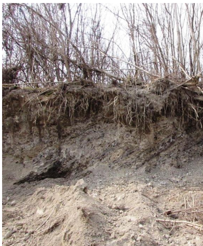
Sl. 36 Prikaz procesa osipanja na haldi 21 (22. 03. 2015.)
