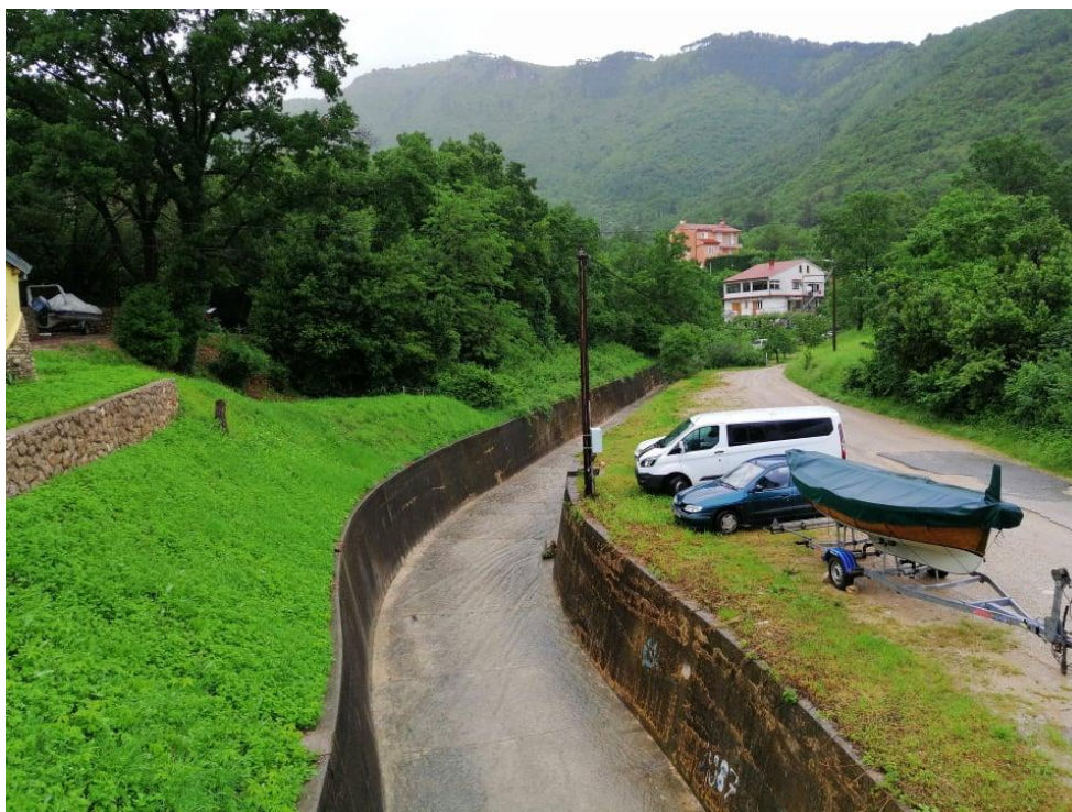
Sl. 65 Reguliran donji tok bujice u naselju Mošćenička draga. Regulacija je izvršena na stogodišnju protoku
