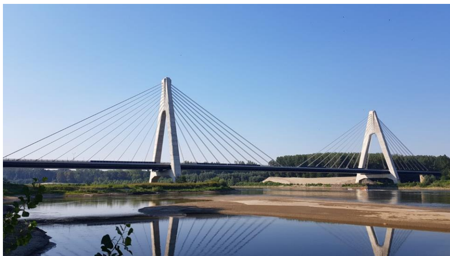
Sl. 2. Novoizgrađeni most koji se nalazi na koridoru Vc preko rijeke Drave, kod naselja Petrijevcu
