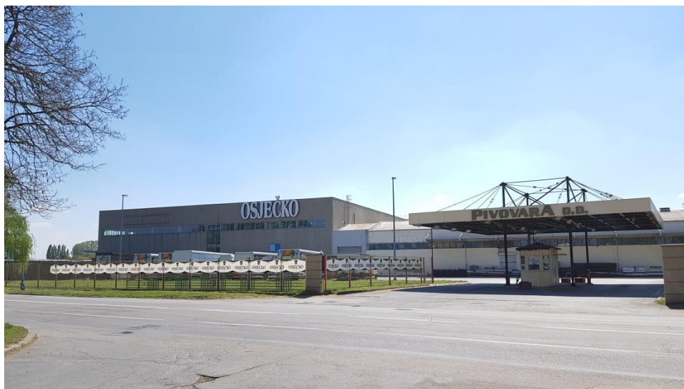
Sl. 32. Zgrada osječke pivovare Snimio: Mislav Zemljak (19. 4. 2019.)
