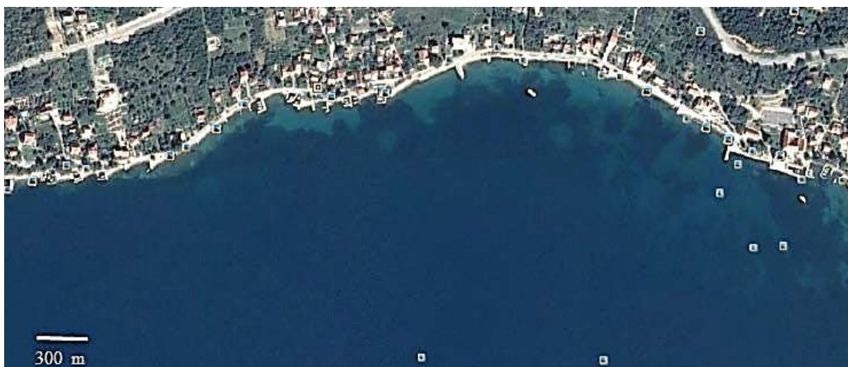
Slika 25. Niz oštećenja uz južnu obalu poluotoka Pelješac (preuzeto sa „Google Earth“)
