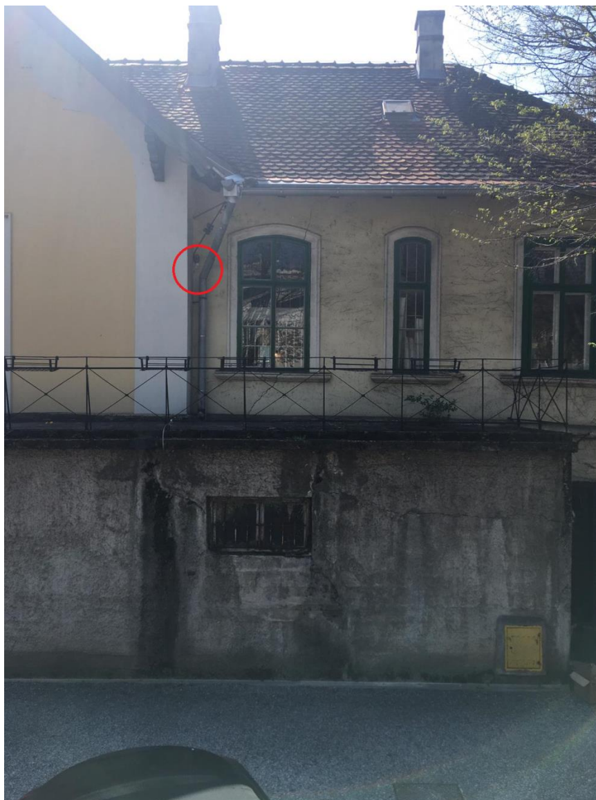
Sl. 10. Mjerni uređaj BO-4 na Upravnoj zgradi u Botaničkom vrtu
