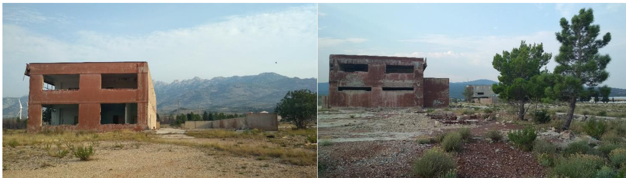
Slika 19. Jedina preostala zgrada crvenog bloka kompleksa Jadral, 24.8.2019.
