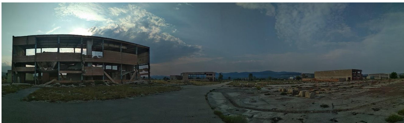
Slika 21. Pustoš i ruševine tvornice Jadral, 24.8.2019.
