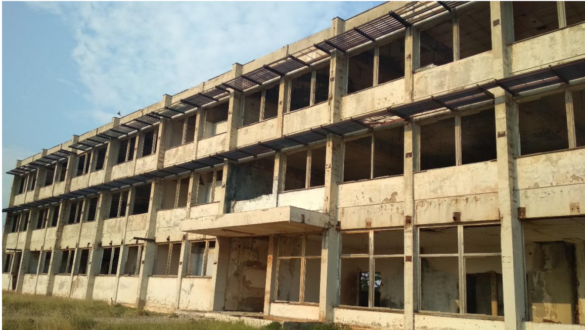
Slika 10. Ostaci jedne zgrade s razbijenim staklima, 24.8.2019.
