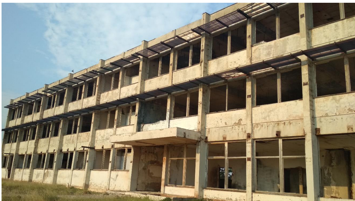
Slika 10. Ostaci jedne zgrade s razbijenim staklima, 24.8.2019.
