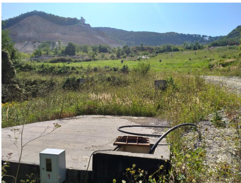
Slika 13. Sabirni bazen za procjedne vode na odlagalištu otpada Gorjak
