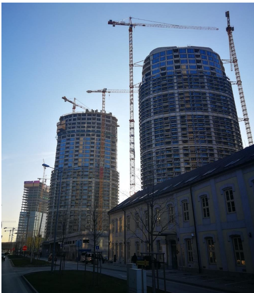
Slika 11. Izgradnja poslovne zone u Bratislavi
