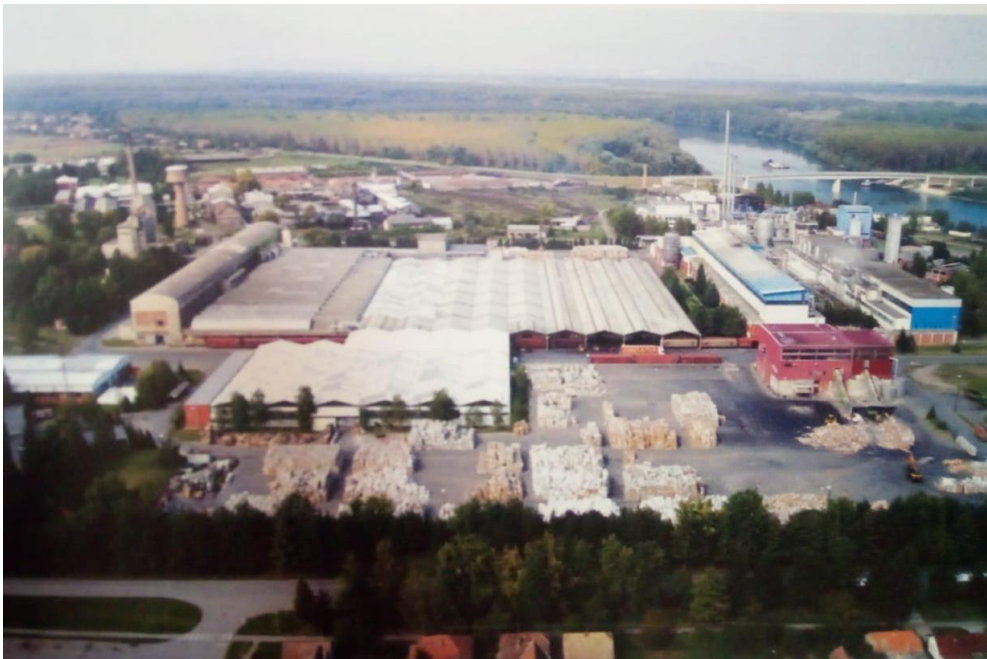
Sl.7. Pogled iz zraka na tvornicu papira i ambalaže
