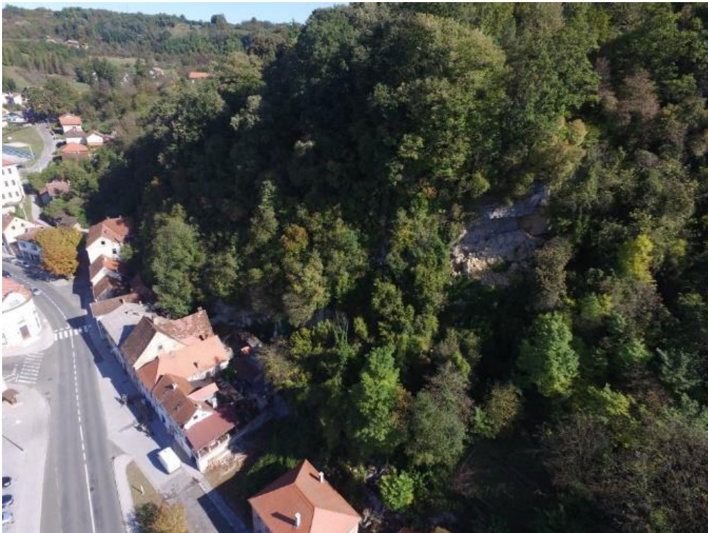
Slika 4.1.1. Odron stijenske mase u ulici Davora Trstenjaka ( www.geotech.hr )
