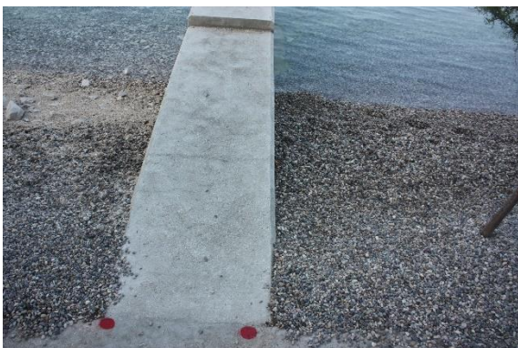
Slika 28. Zapunjenost sedimentom do razine šetnice na DRN (2.7.2018.).
