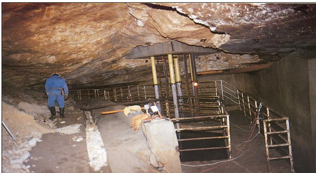
Sl. 20. Vodozahvat Tunel Učka
