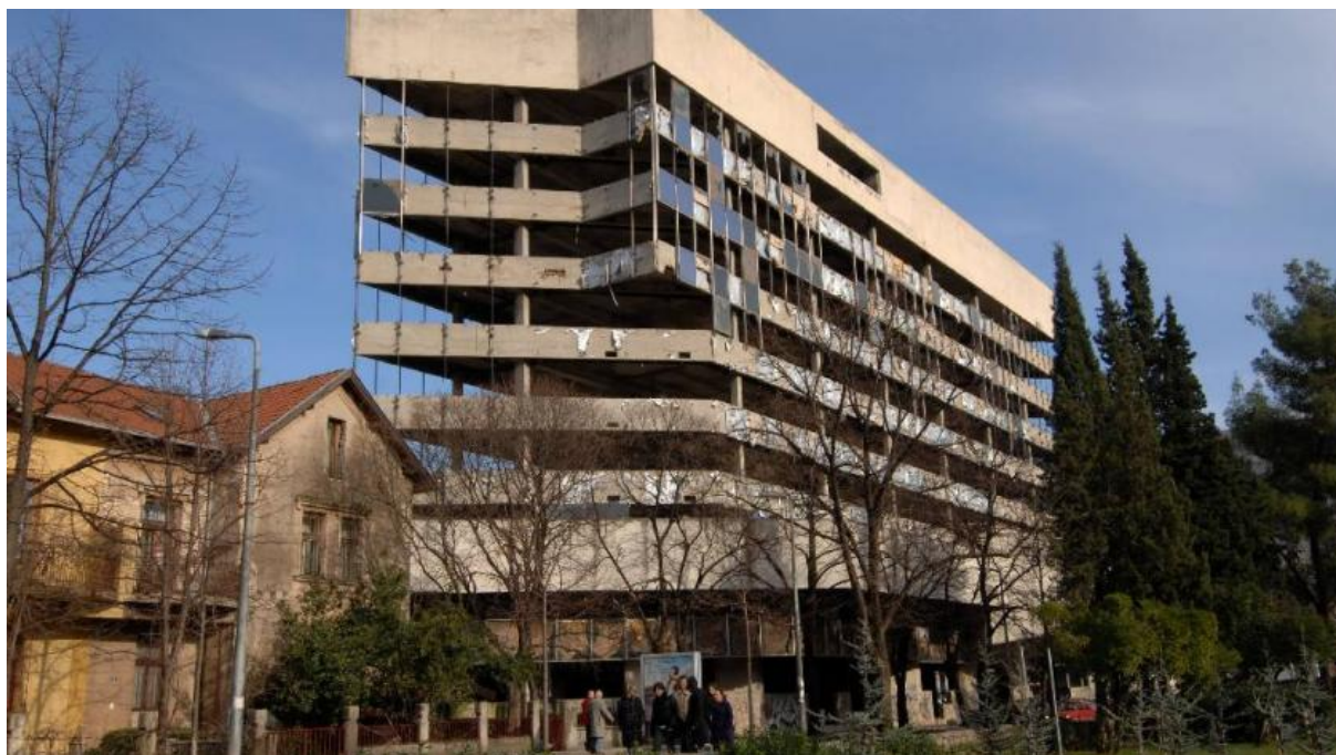
Sl. 29. Primjer propalog projekta izgradnje poslovnog objekta Staklena Banka
