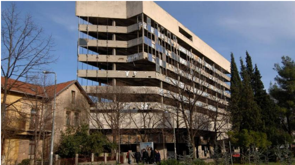
Sl. 29. Primjer propalog projekta izgradnje poslovnog objekta Staklena Banka
