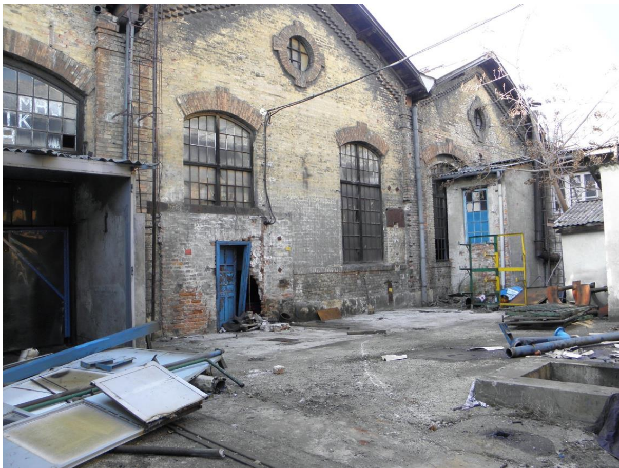
Sl.14. Uništeni sklop Tvornice željezničkih vozila „Gredelj“
