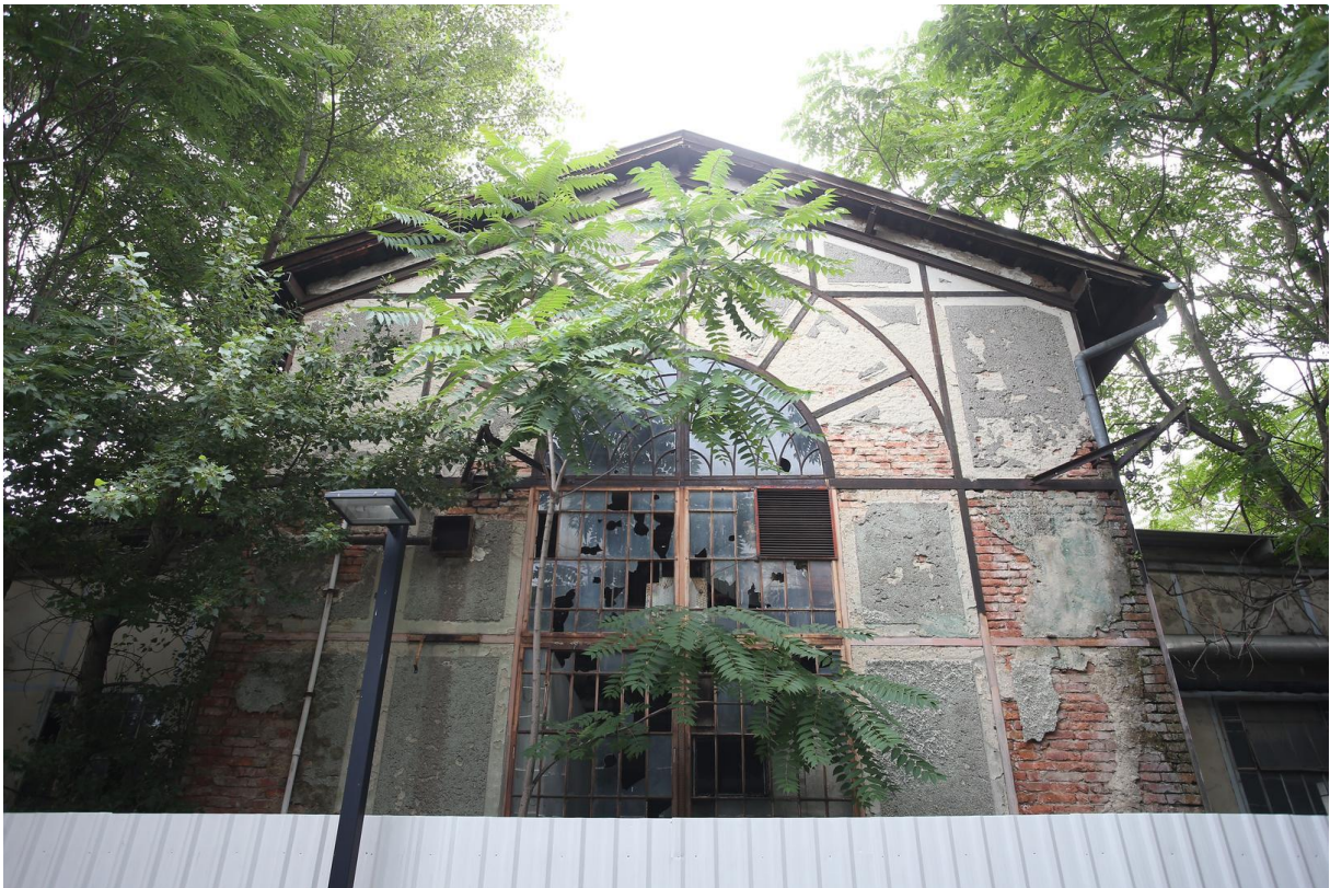
Sl.15. Pogonska zgrada negdašnje tvornice svijeća „Iskra“
