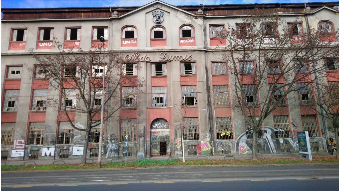
Sl.19. Tvornica „Nada Dimić“, pogled s Branimirove ulice
