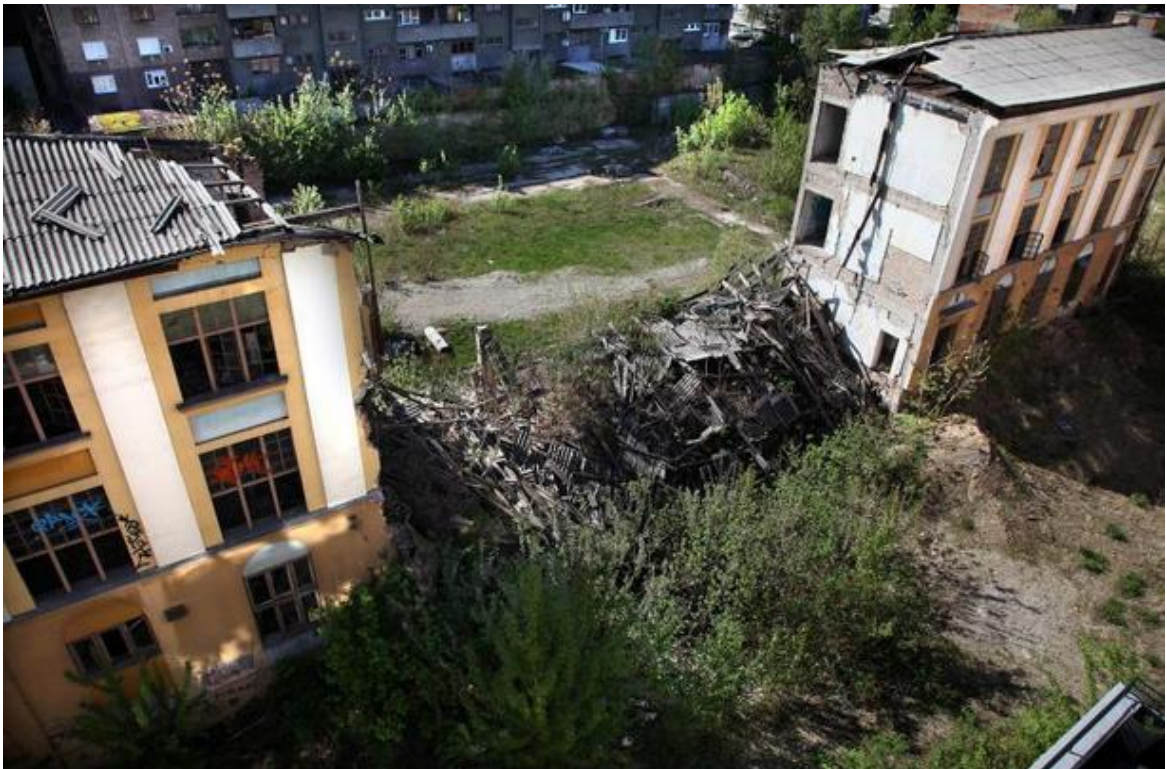
Sl.18. Uništeni dio Tvornice „Nada Dimić“
