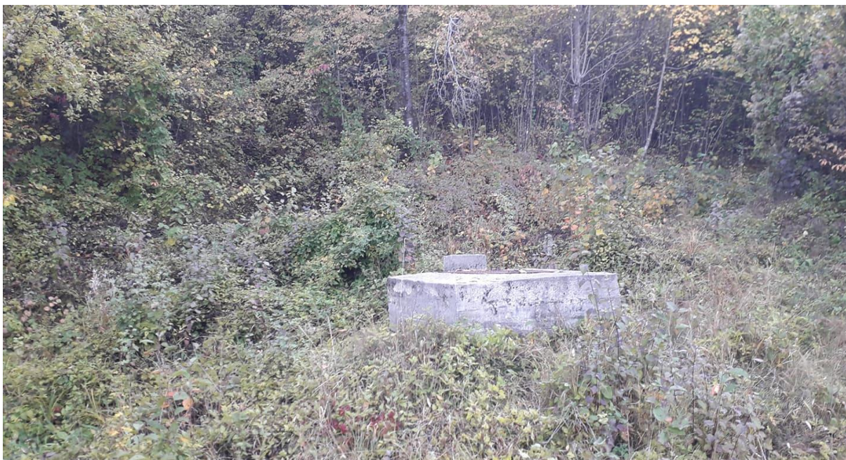
Sl. 11. Sabirni bazen vodovoda Glavice (7. srpnja, 2019.)
