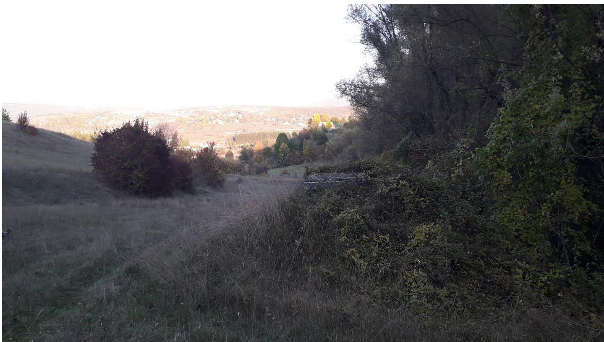
Sl. 12. Akumulacijski bazen vodovoda Glavice (7. srpnja, 2019.)
