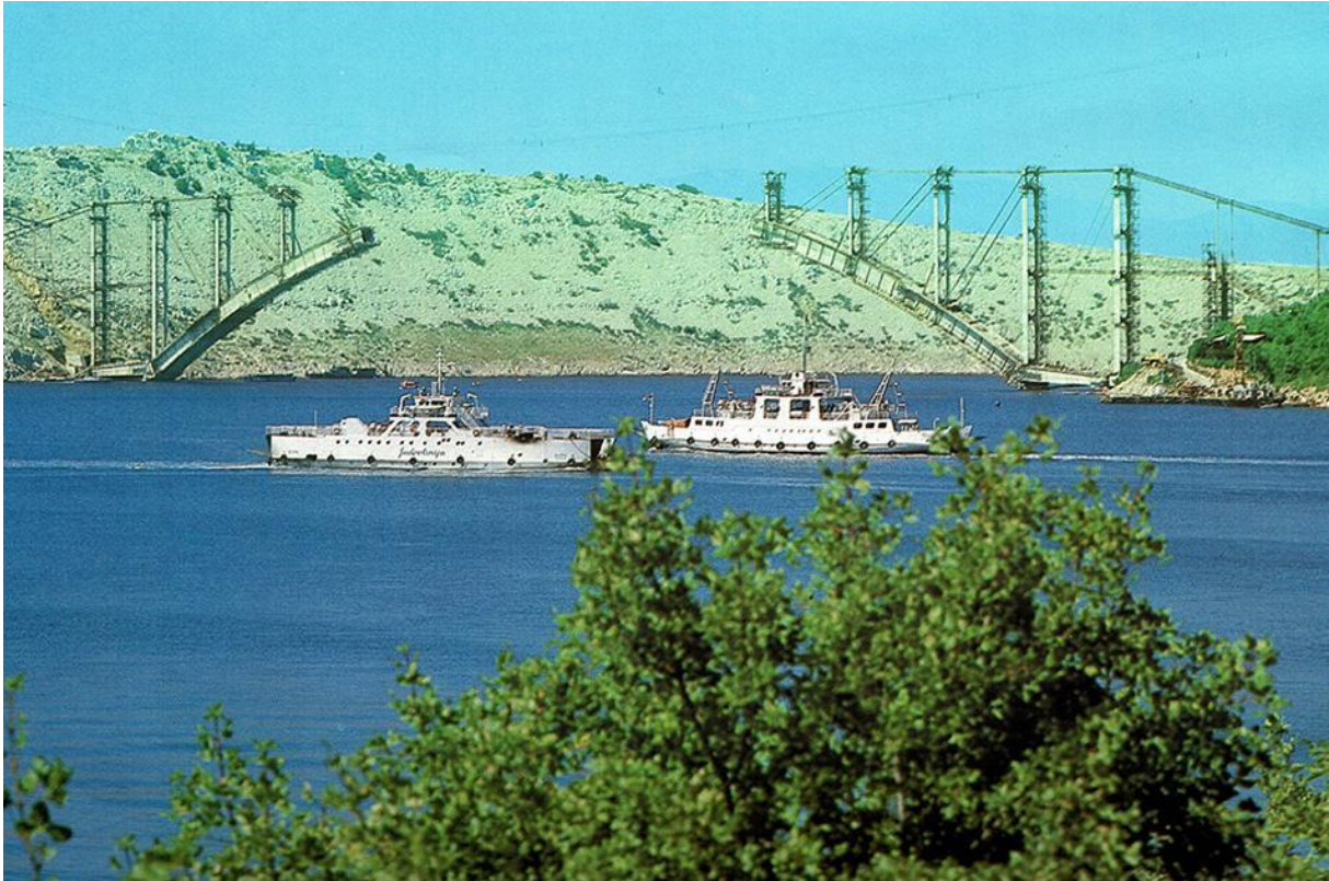
Sl. 7. Gradnja Krčkog mosta
