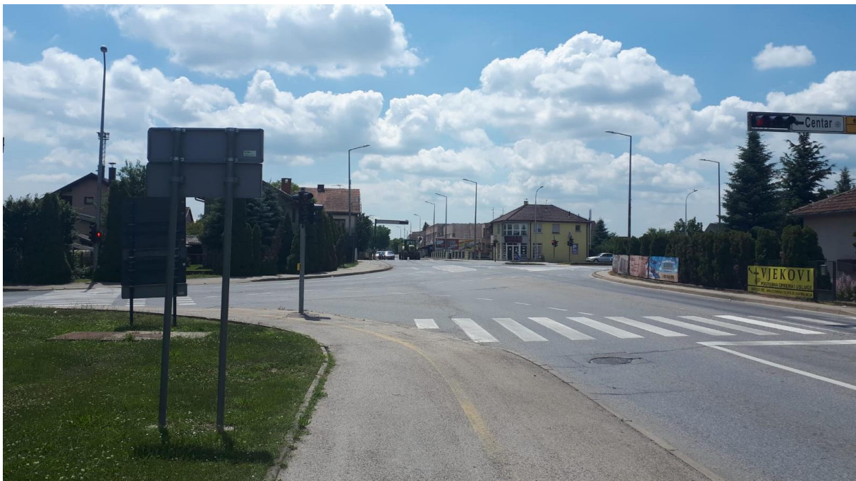
Sl. 9. Pogled na raskrižje D2 i D20
