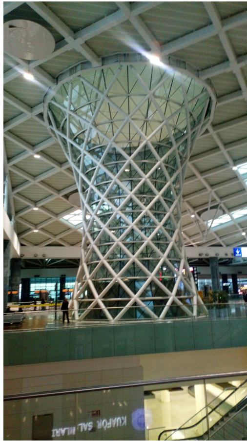
Slika 0.1: Hiperboloid na aerodromu u Izmiru, Turska (slika: FMB 2017)
