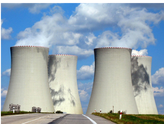
Slika 3.4: Dimnjaci nuklearnih elektrana
