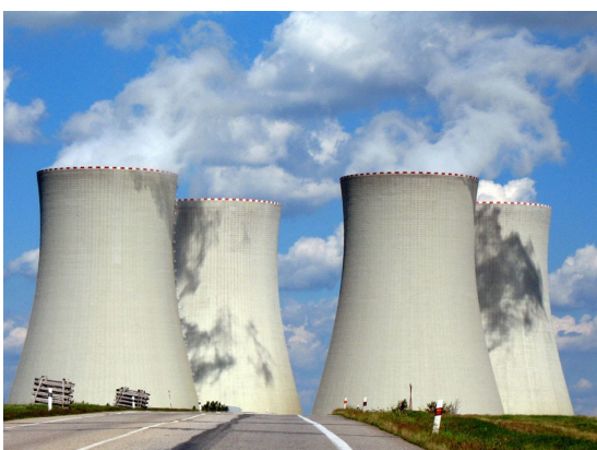
Slika 3.4: Dimnjaci nuklearnih elektrana
