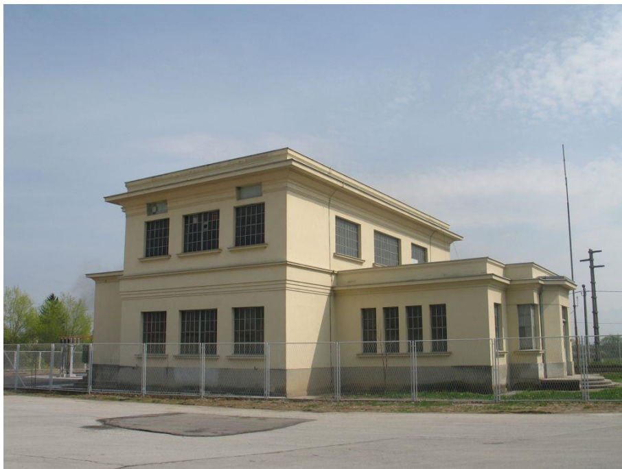
Sl. 24. Zgrada transformatorske stanice Ilovac iz 1930. godine
