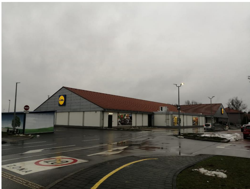
Sl. 18. Lokacija bivše tvornice „Josip Kraš“, danas Lidl
