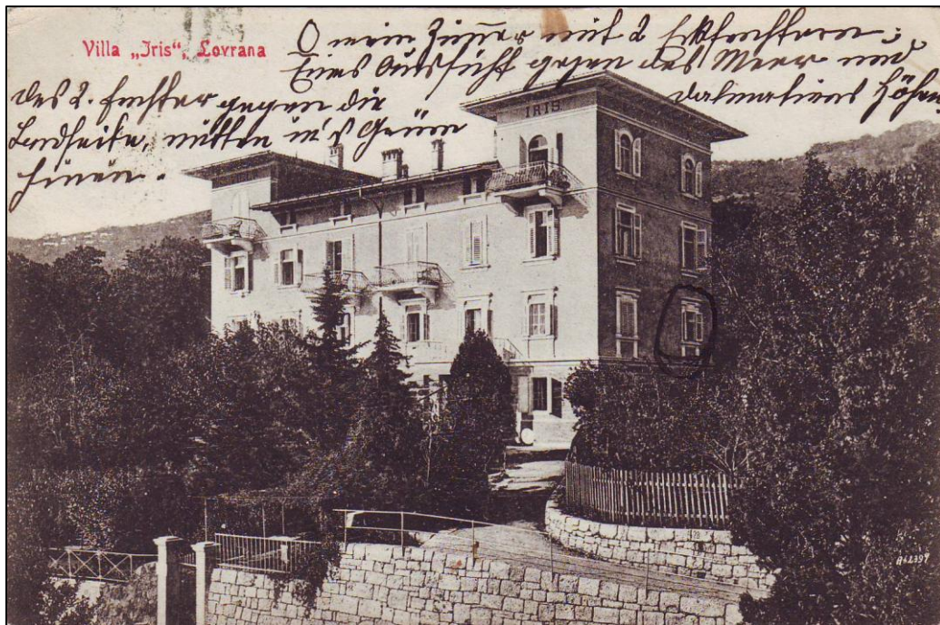
Sl. 25. Vila Iris – primjer komerijalne izgradnje vila s početka 20. stoljeća
