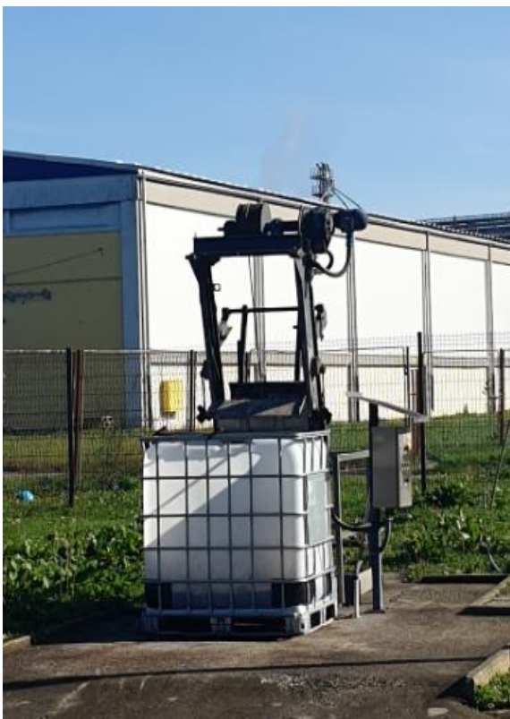
Sl.24. Gruba rešetka za prethodno pročišćavanje Izvor: Vlastite fotografije (2020.)
