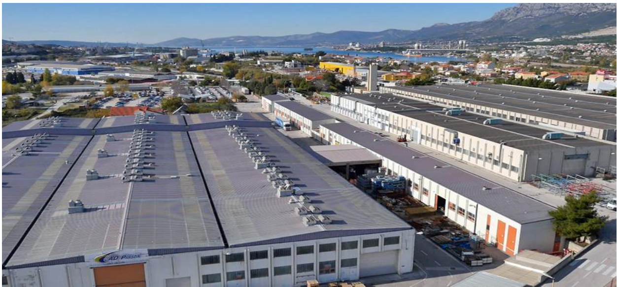
Slika 10: Sjedište i postrojenje AD Plastik d.d.
