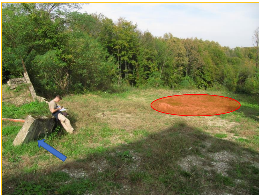
Slika 29. Mjesto srušenog objekta označeno crvenim krugom (objekt se nalazi na ortofotu) i proklizali dio zida označen strelicom (fotografirano tijekom terenskog kartiranja 2020. godine).
