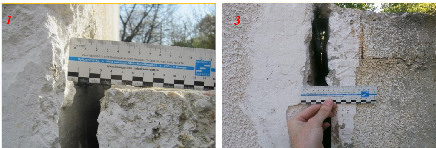
Slika 39. Mjerenje pukotine na točki D4a. 1 - prvo mjerenje (listopad 2019. godine), 3- treće mjerenje (srpanj 2020. godine).
