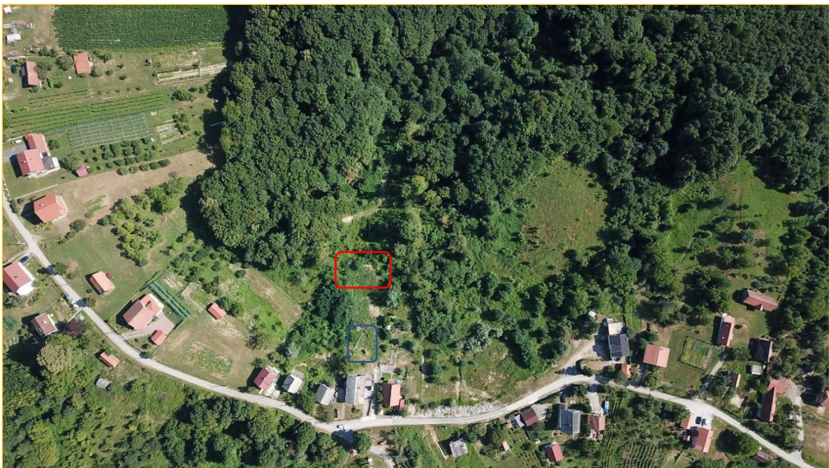
Slika 45. Aerofotografija snimljena dronom DJI Mavic Pro 1 2020. godine s označenim položajem (uklonjenog) srušenog objekta i mjesta mijenjanja položaja odvodne cijevi .
