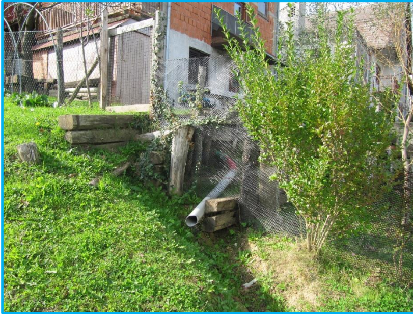
K2-photo- 149/405- odvodnja direktno u čelo klizišta.
