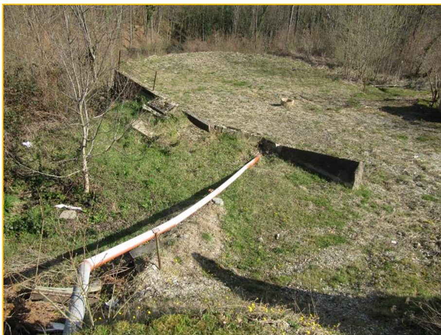
Slika 36. Prikaz cijevi za odvodnju iz perspektive točke D2 i otklizalog zida (fotografirano tijekom terenskog kartiranja 2020. godine).
