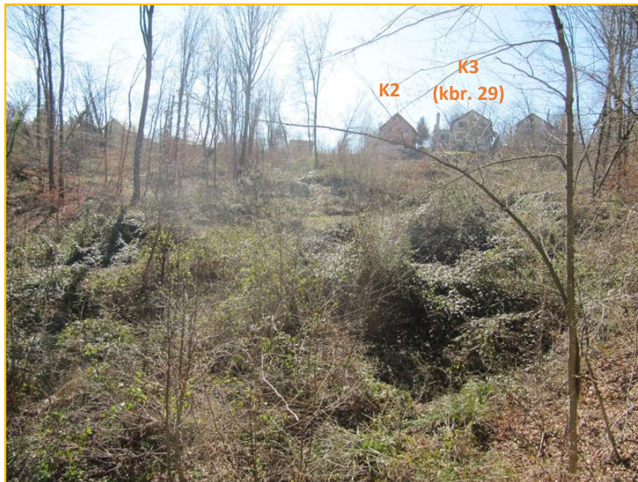
Slika 30. Tijelo klizišta - obraslo, izrazito deformiran strmi teren s pukotinama i vidljivim najahivanjima (fotografirano tijekom terenskog kartiranja 2020. godine).
