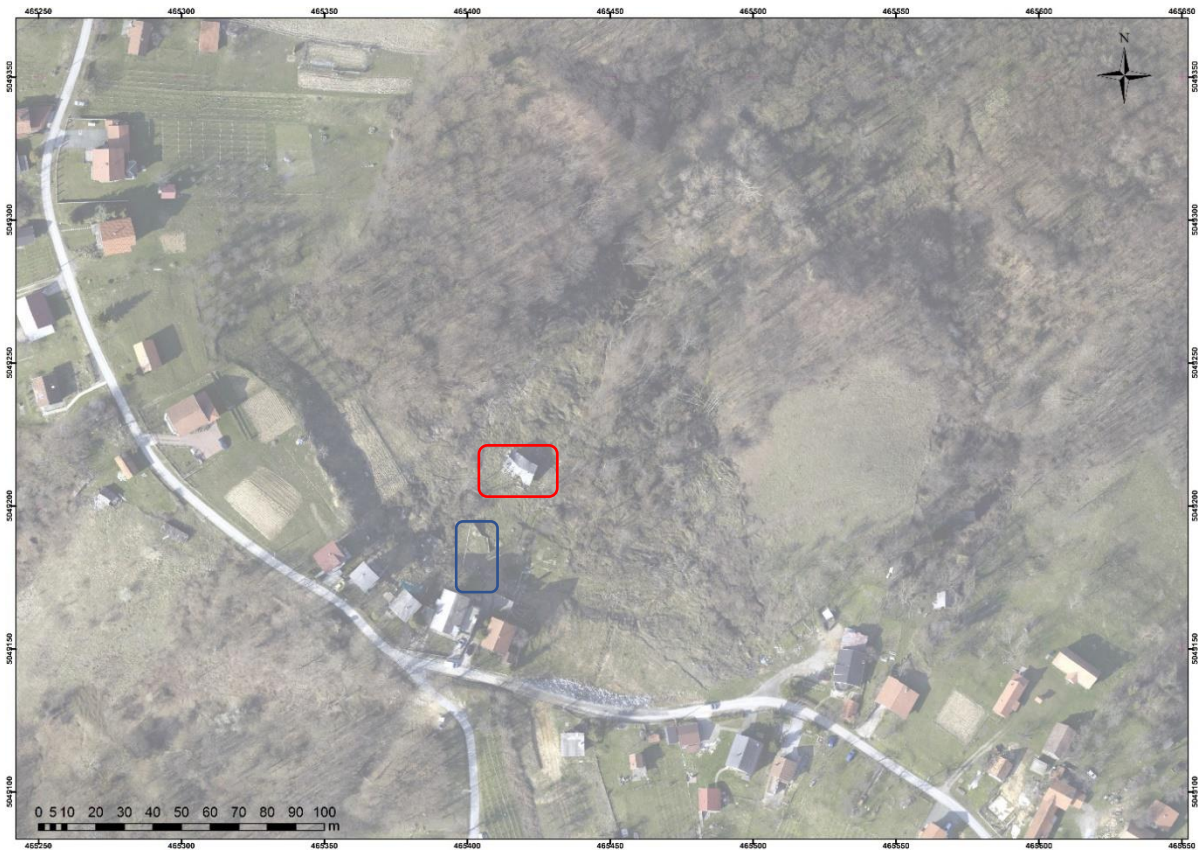
Slika 44. Ortofotografija iz 2018. godine s označenim otklizalim objektom i mjestom mijenjanja položaja odvodne cijevi .
