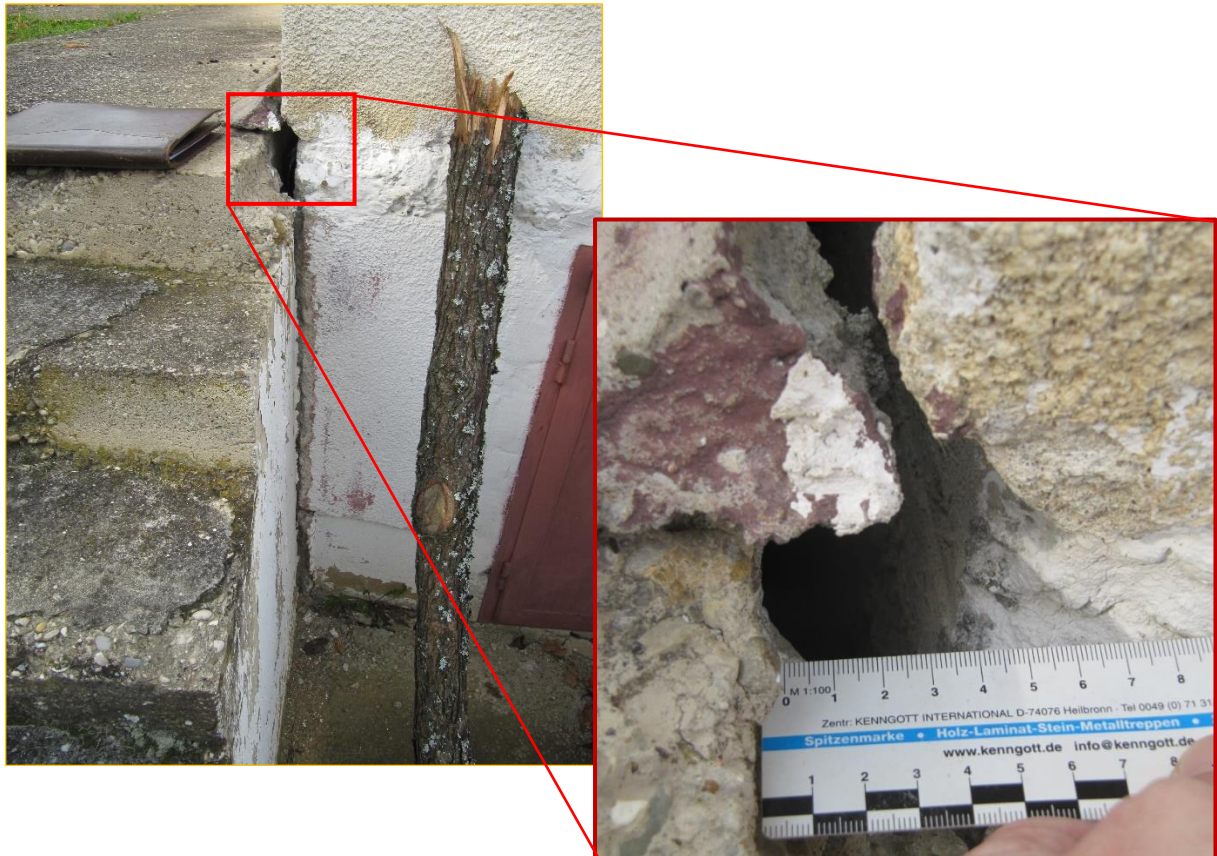
Slika 40. Prvo mjerenje pukotine D4b (listopad 2019. godine).
