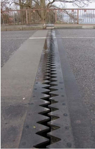
Slika 19. Uski kanalić preko širine mosta 55
