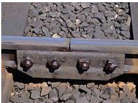
Slika 17. Primjer procijepa na tračnicama 56
