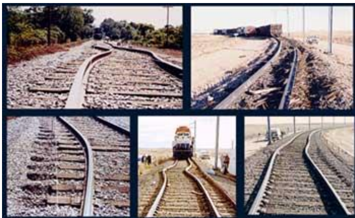
Slika 18. Izobličenje na tračnicama zbog zagrijavanja 55
